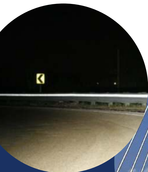
Glissière de sécurité
